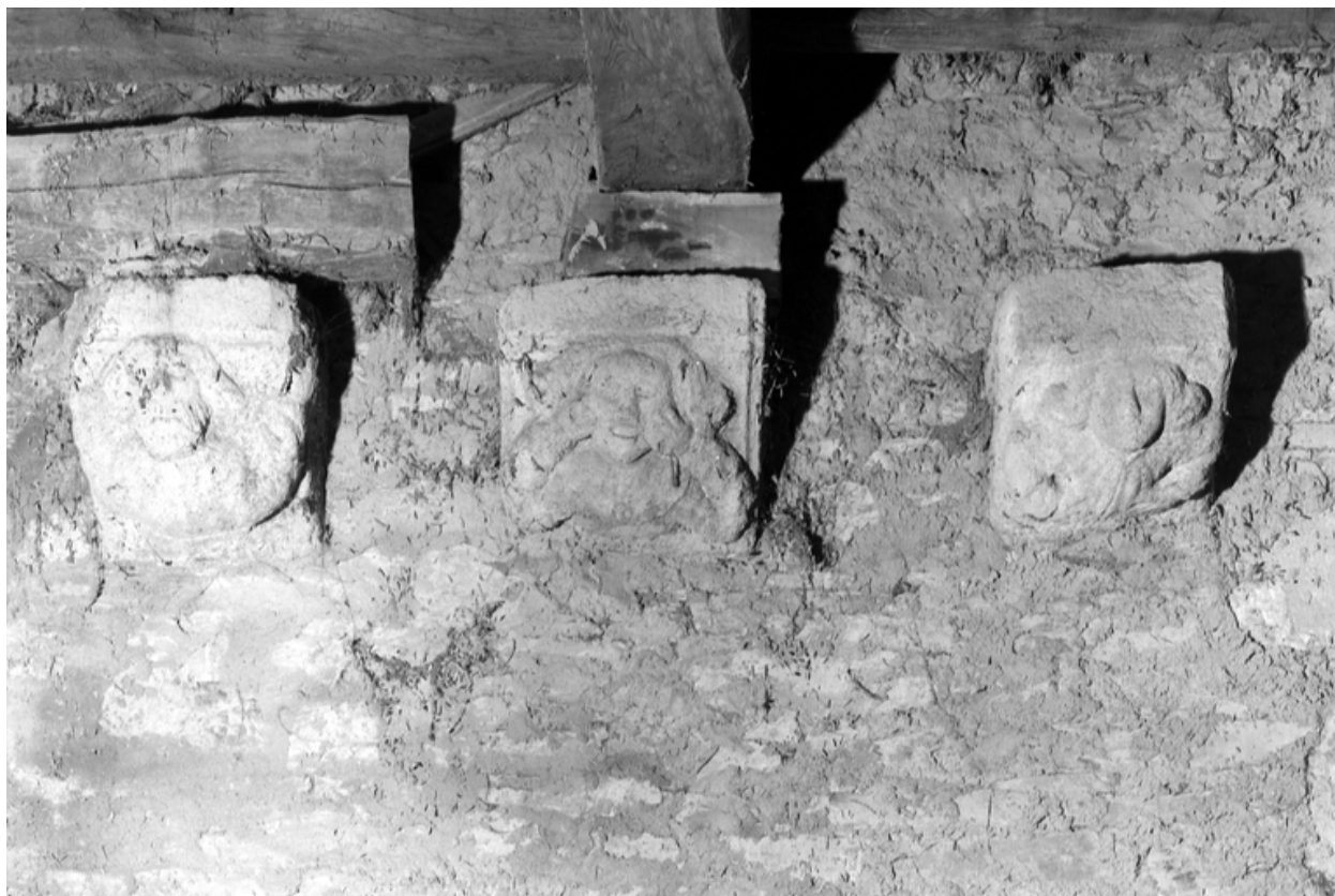
Corbeaux : pièce d'étage ouest
