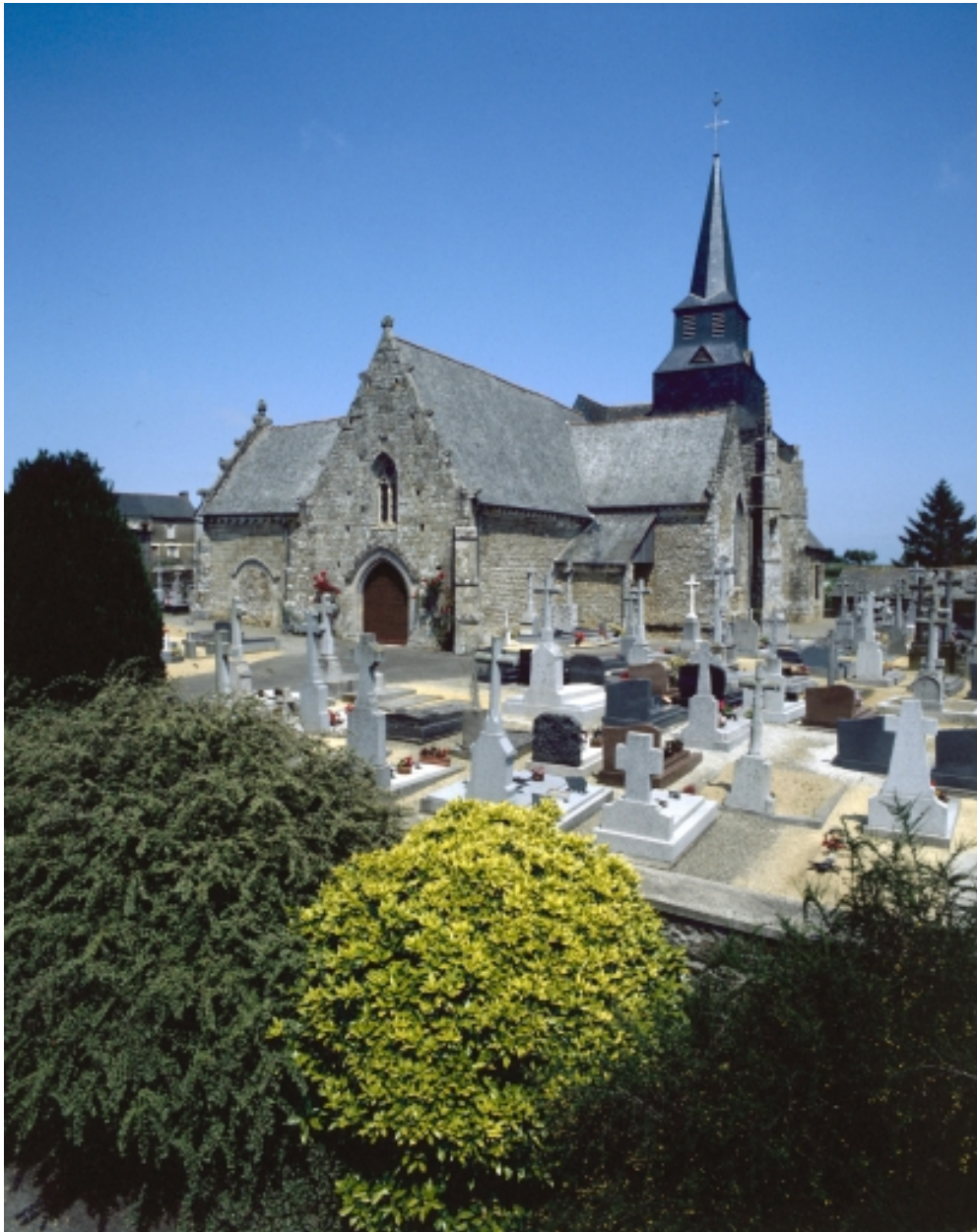
Elévation Sud-Ouest : vue générale
