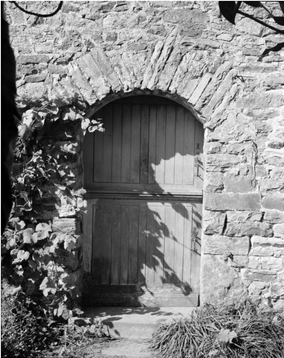
Logis, détail de la porte.
