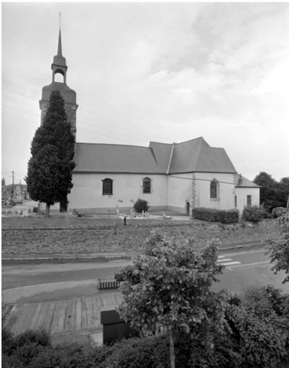
Elévation sud : vue générale
