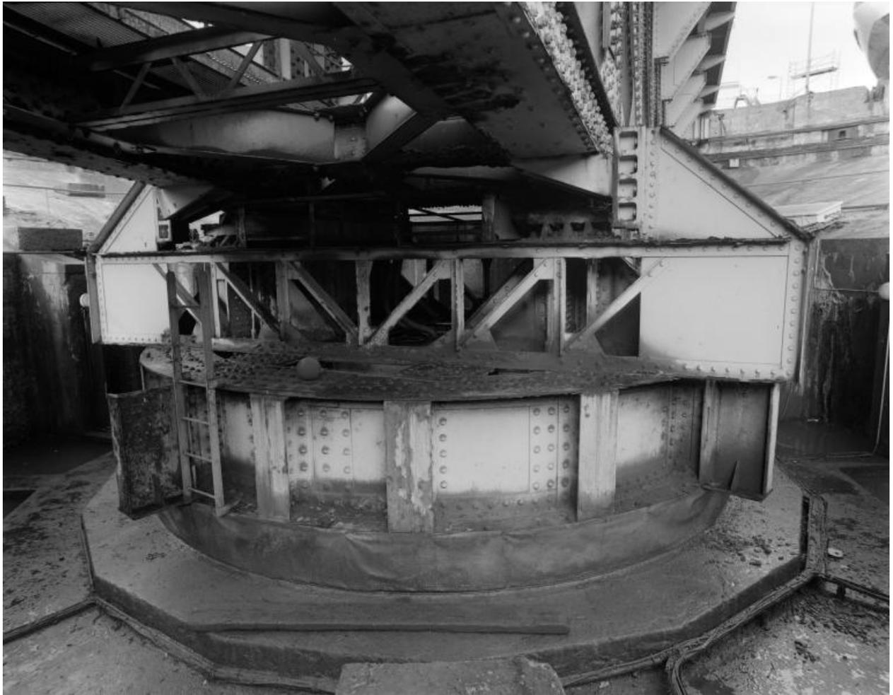
Vue de détail du pont basculant et tournant dans sa fosse bétonné en 2000 : axe central
