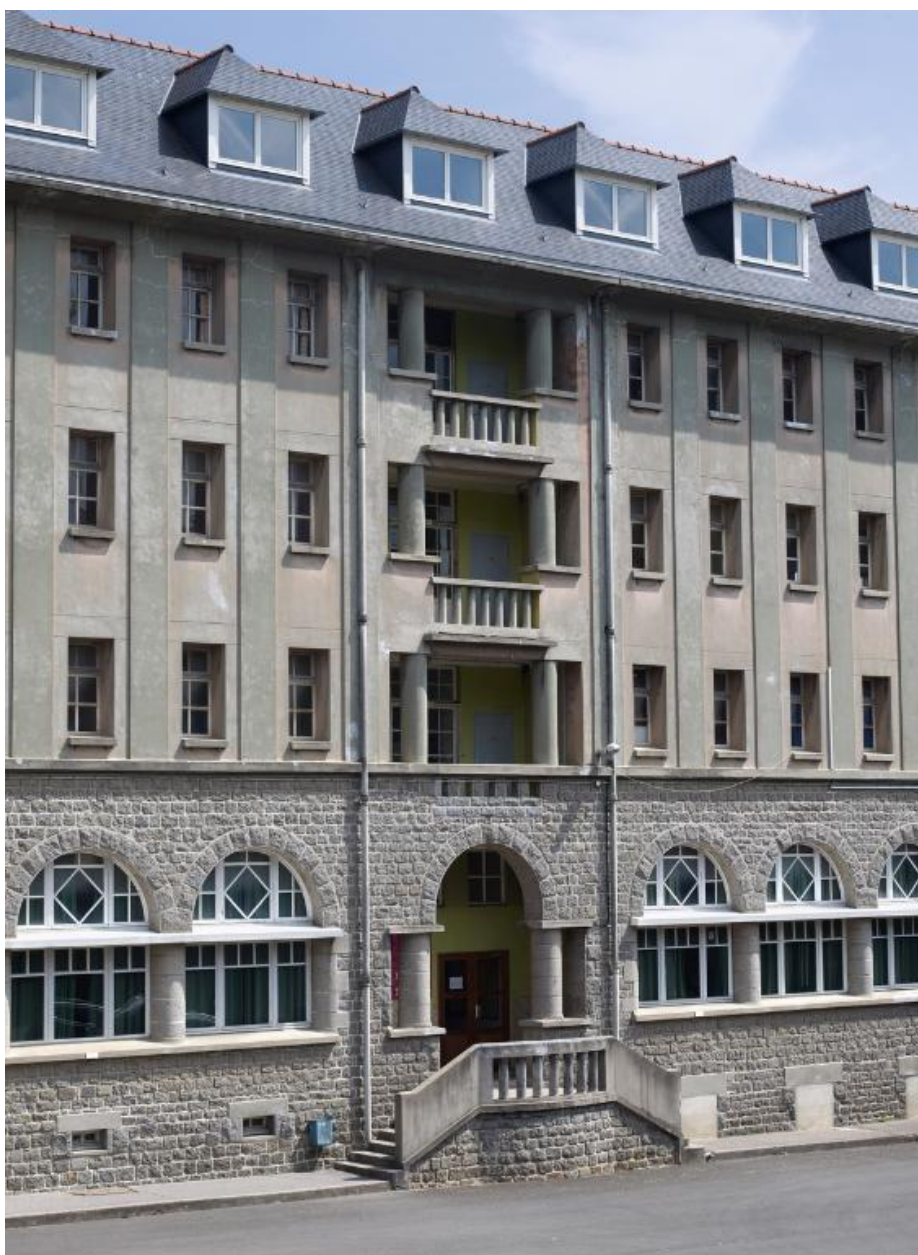
Façade de l'internat (G-R. Lefort, architecte, 1936-1938) : détail sur la travée de l'escalier et les travées adjacentes.
