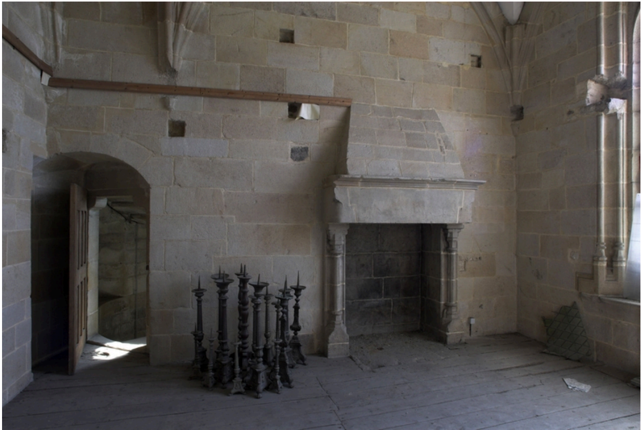
Pièce au dessus de la sacristie, vue vers la cheminée
