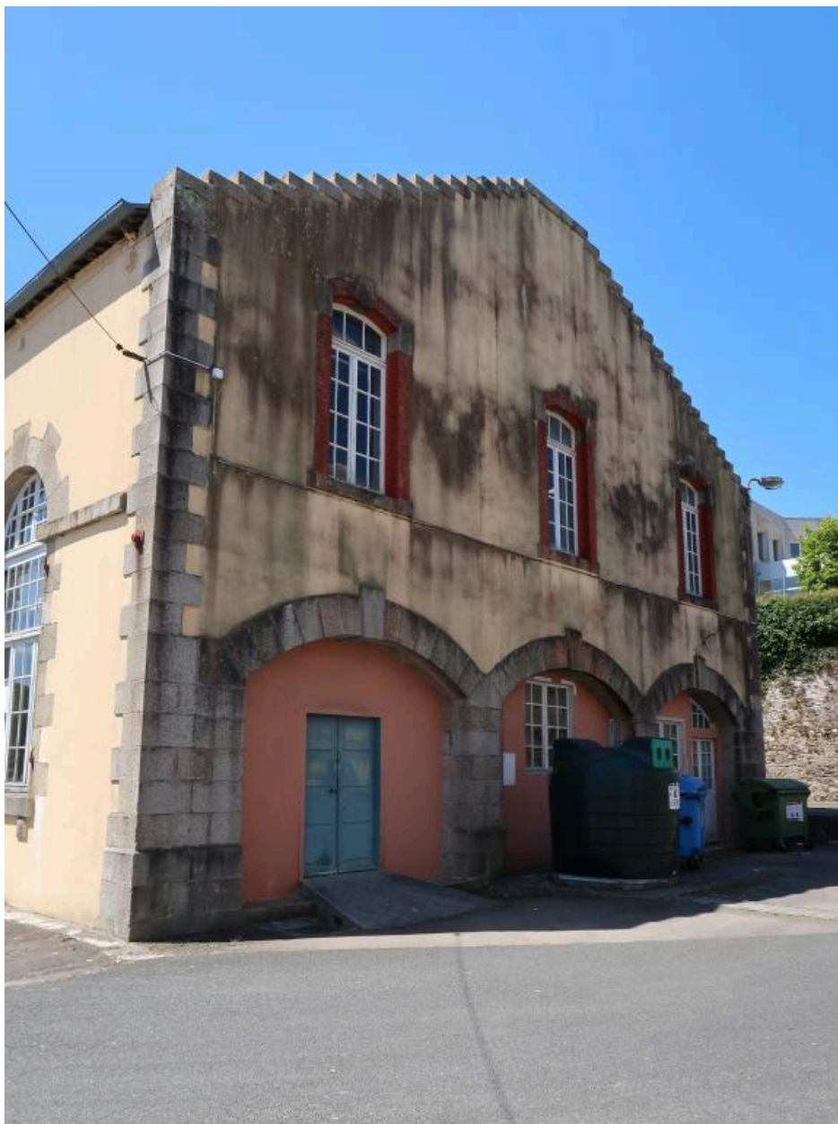
Vue du pignon est (état en 2022)
