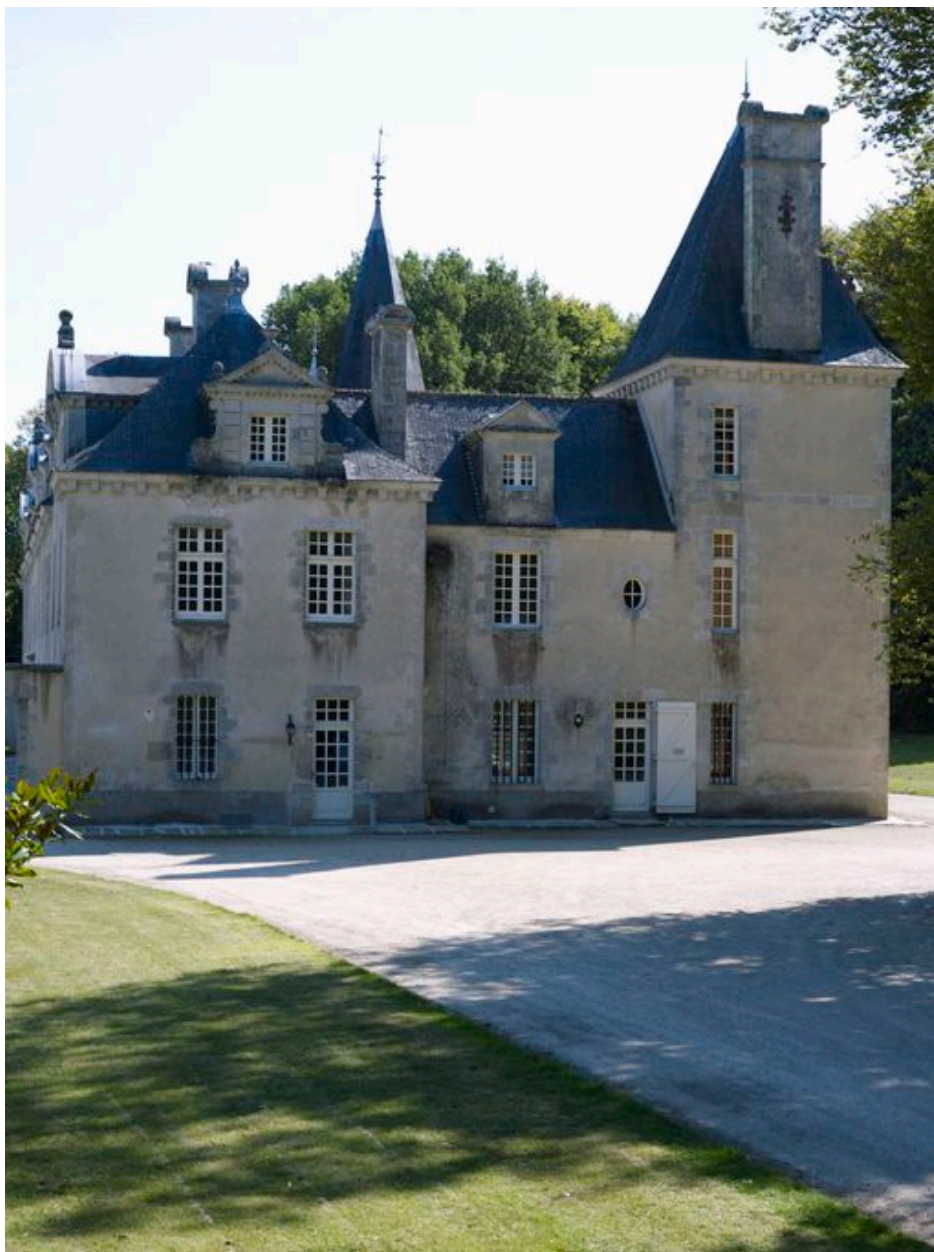
Château, corps de logis : élévation nord (état en 2010)
