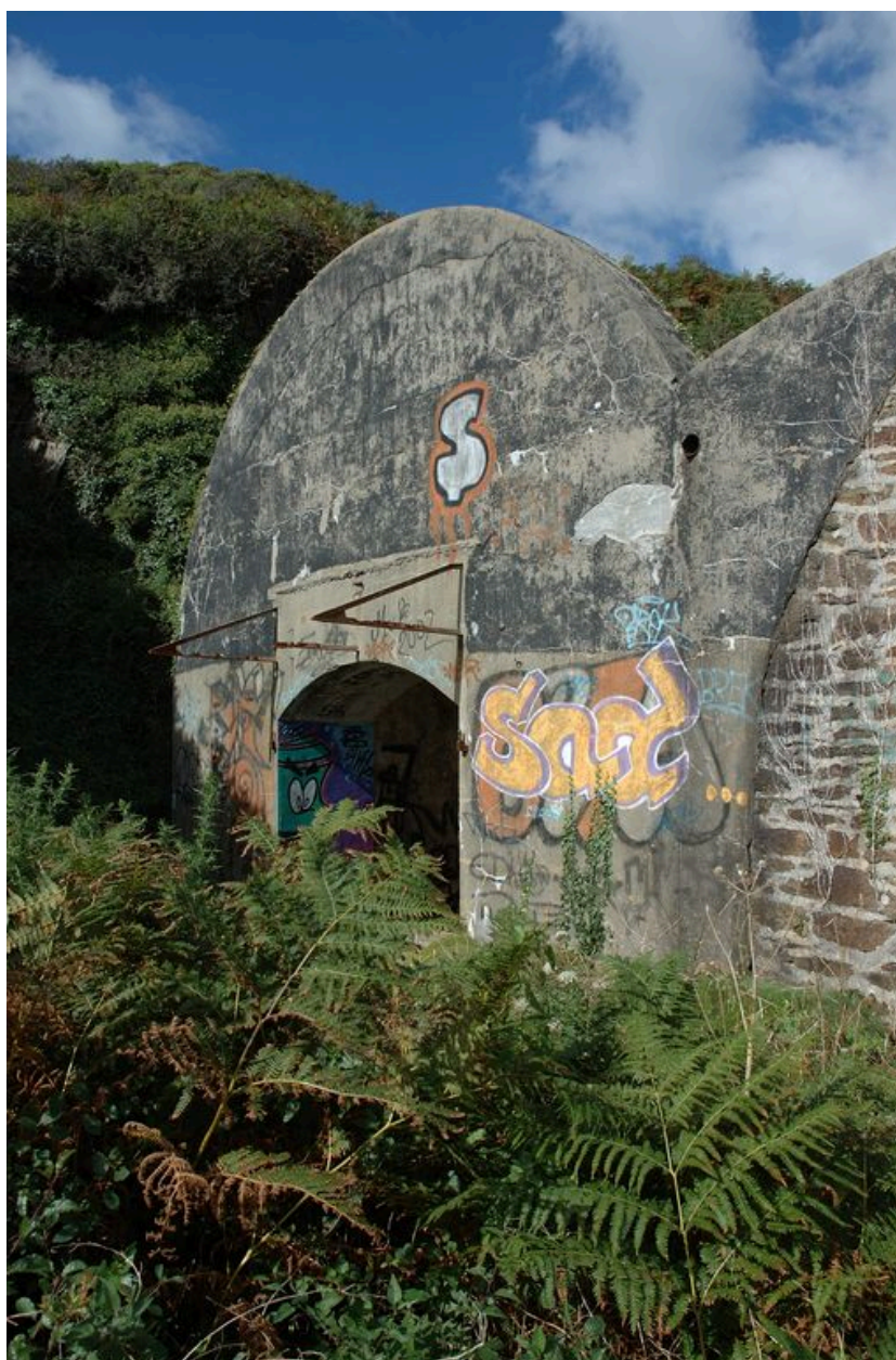
Vue des casemates de projecteur (état en 2007)
