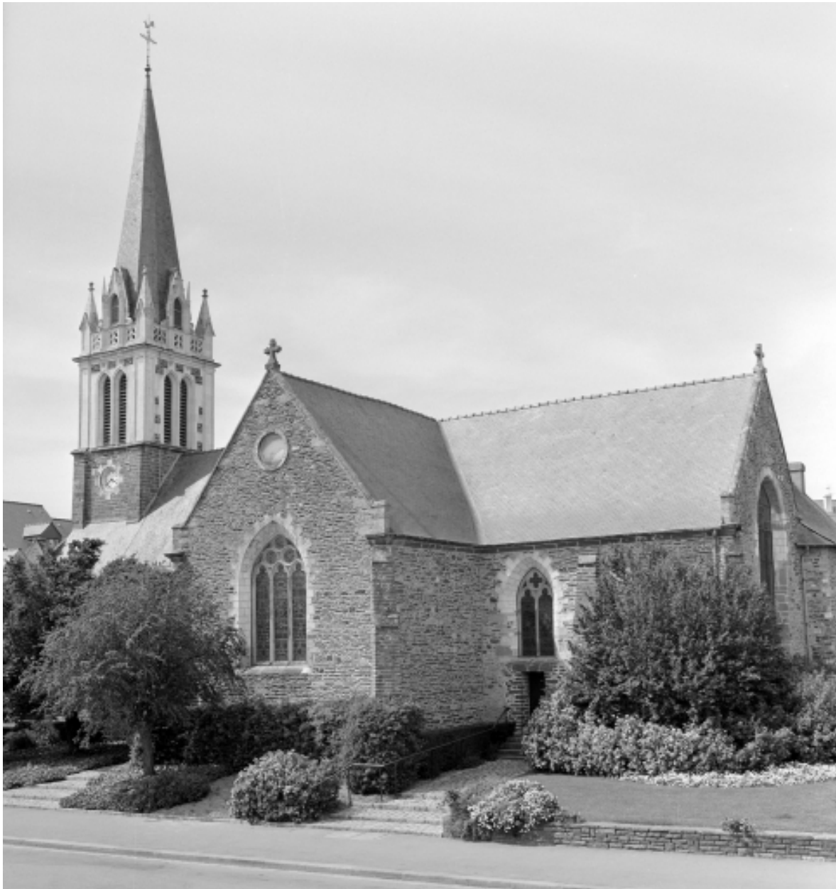
Elévation Sud-Est : vue générale
