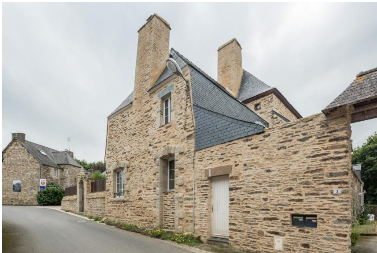
Logis, pavillon latéral, vue générale nord-est
