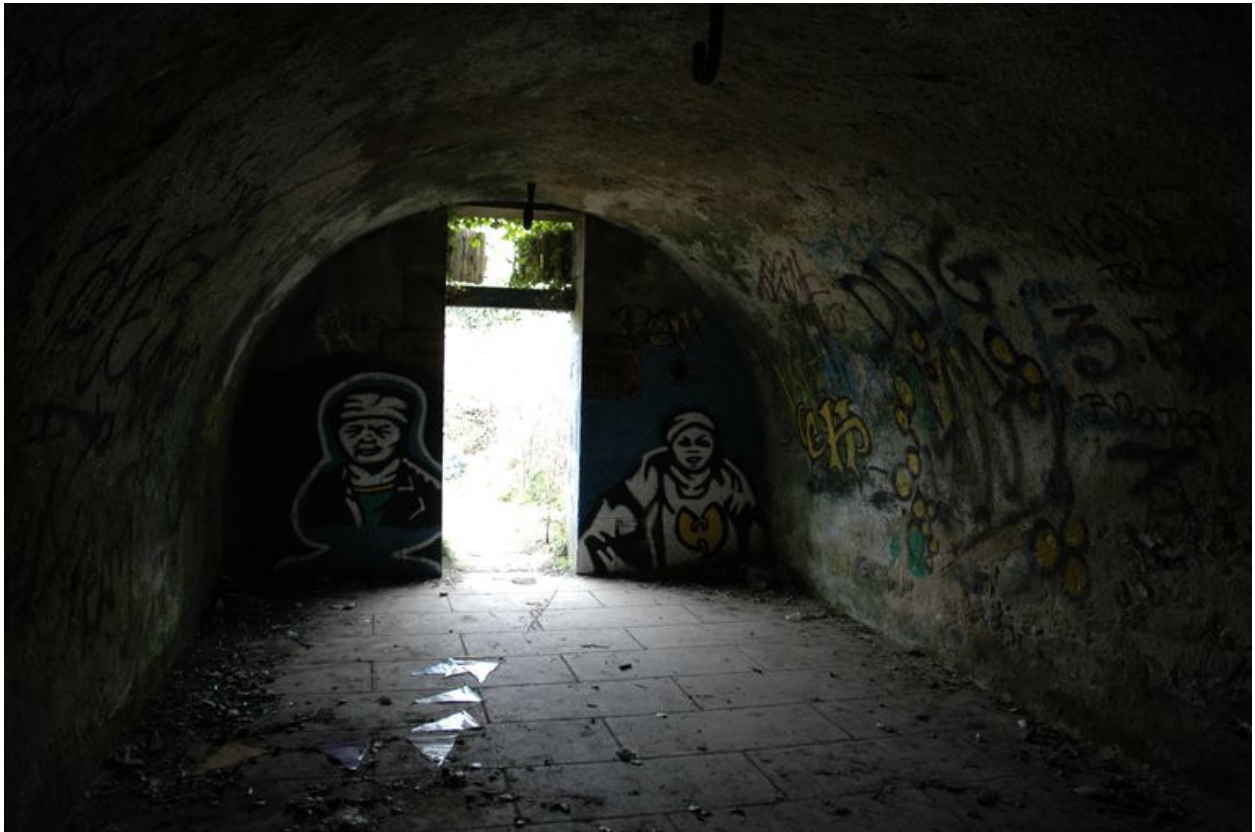
Vue de l'abri à munition est (état en 2005)
