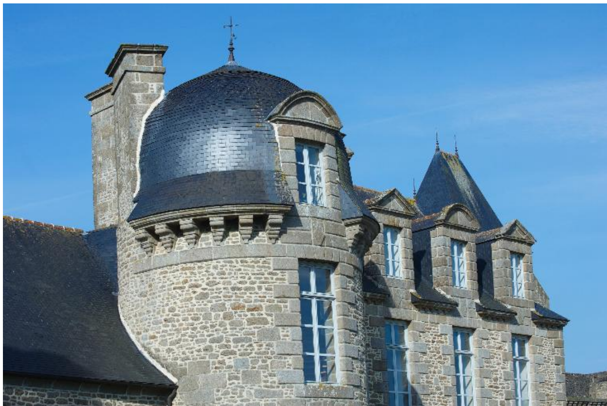
Vue sur les toitures
