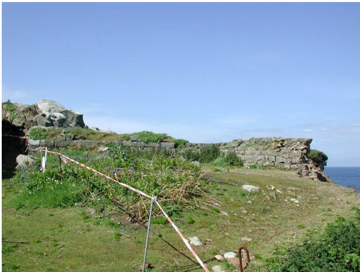
Vue de la batterie nord-ouest en partie effondrée de l'île aux Moines
