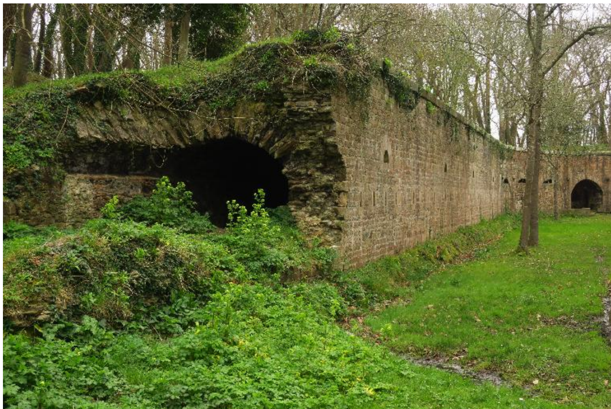
Le Palais, enceinte urbaine, galerie de contrescarpe, extrémité gauche.
