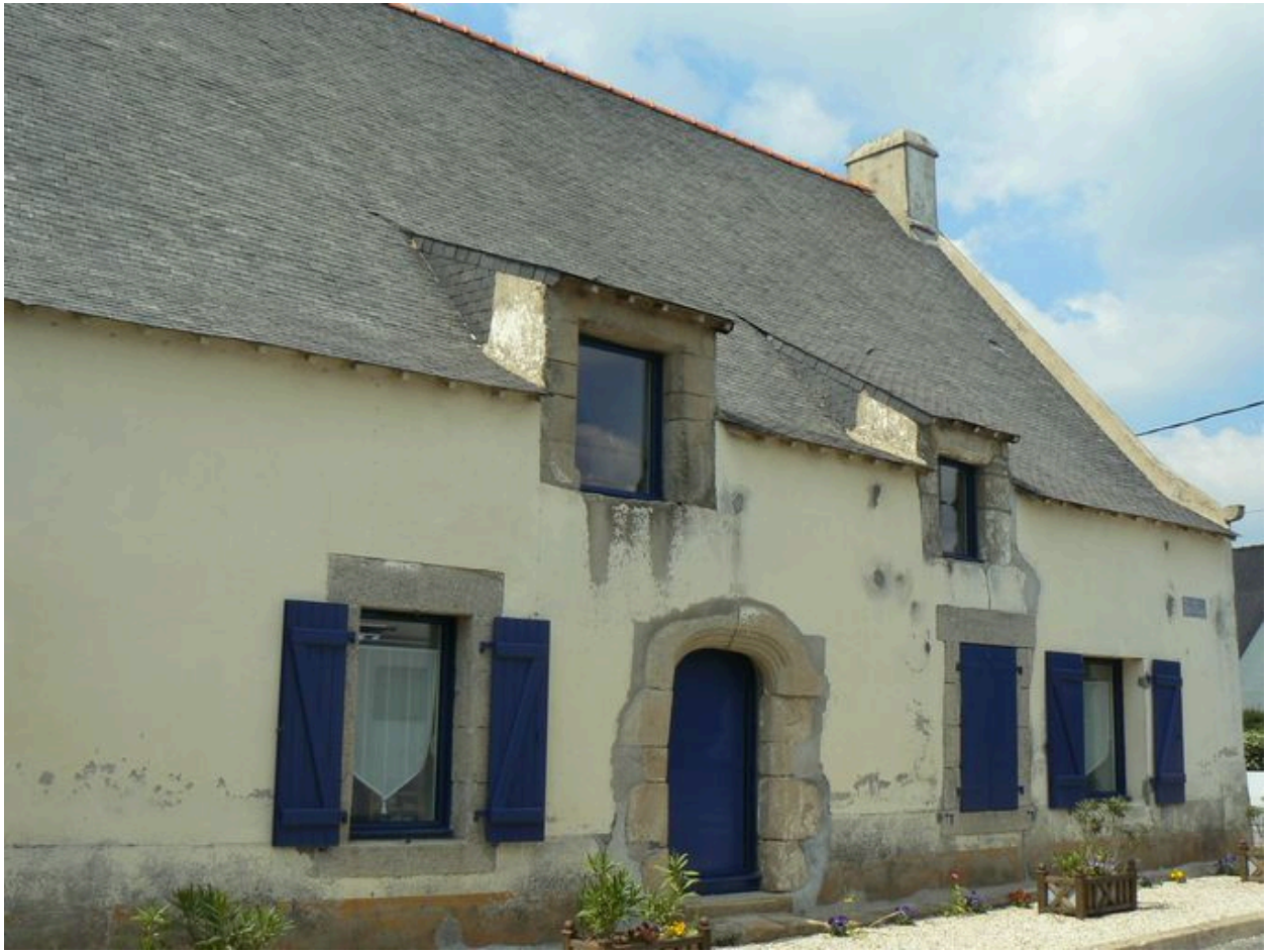
Vue générale de la maison du 2 rue des Algues
