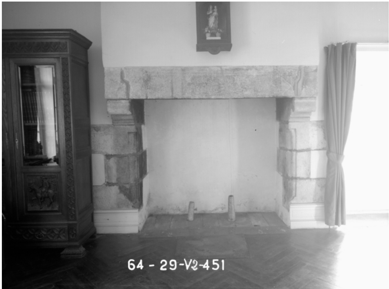
Rez-de-chaussée, cheminée ouest du pavillon ouest
