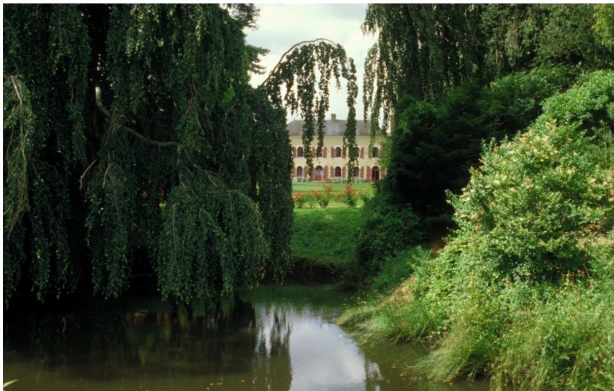
Vue de situation sud
