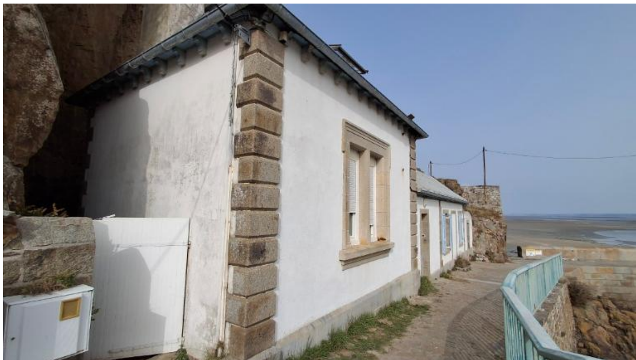
Elévation principale, vue rapprochée
