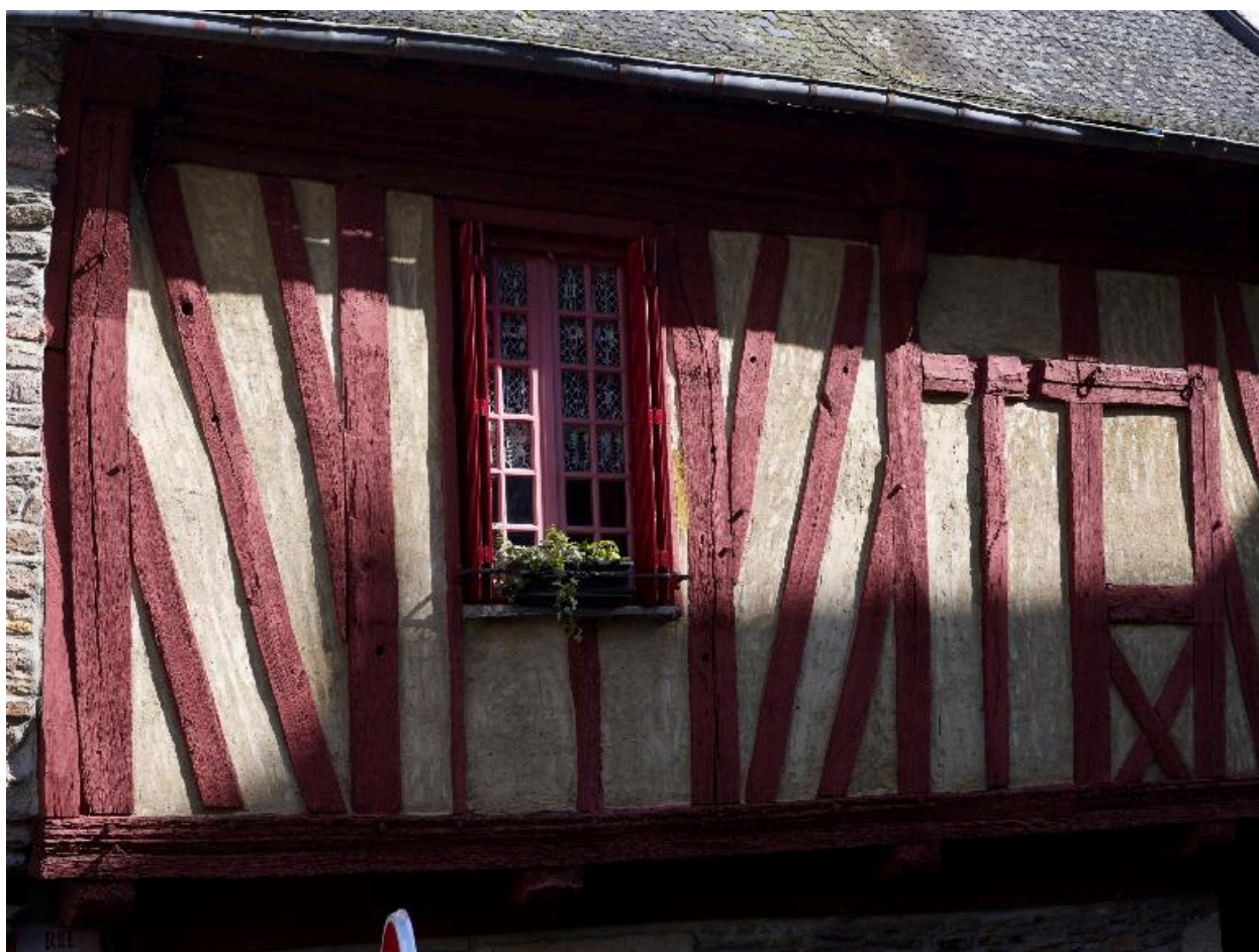
Maison, élévation donnant sur la rue du Lion d'Or : le pan de bois (état en 1988)
