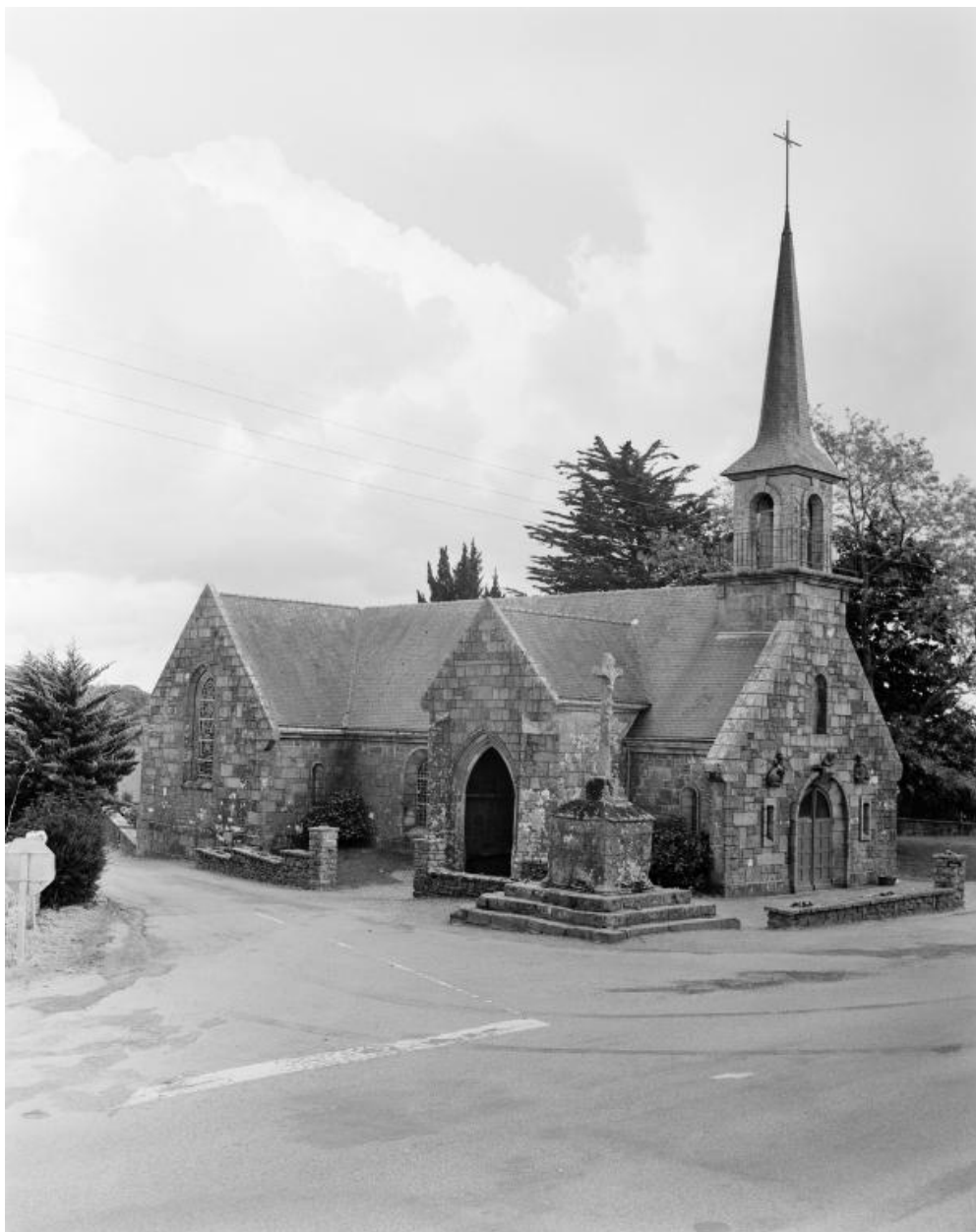
Vue générale ouest.
