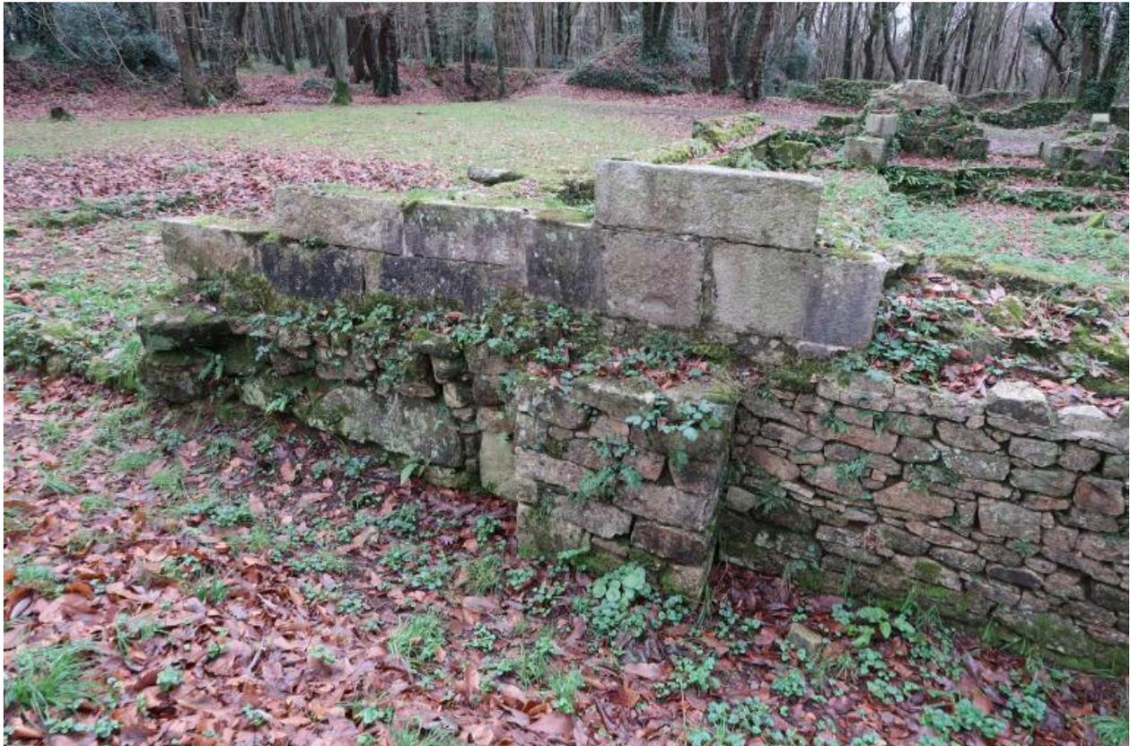
Vue du mur est (chevet plat). On distingue trois types différents d'appareillage (moellon et pierre de taille de granite). Cette portion de mur correspond à la création du bas-côté au sud
