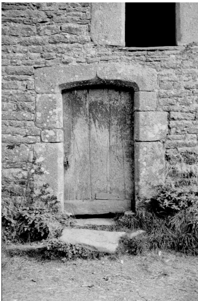
Ferme 4 : la porte (état en 1969)
