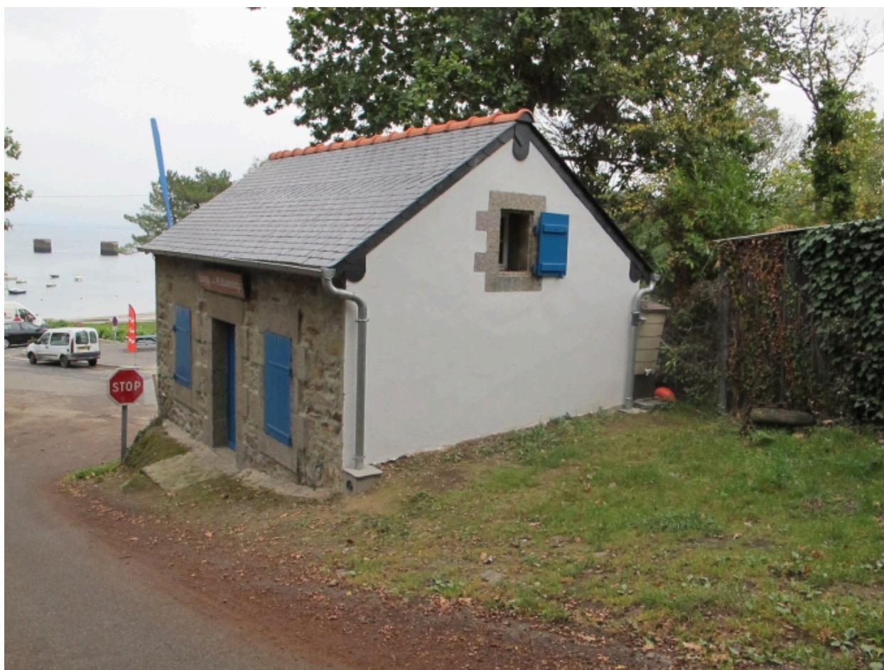
Maison des douanes, façade nord-ouest
