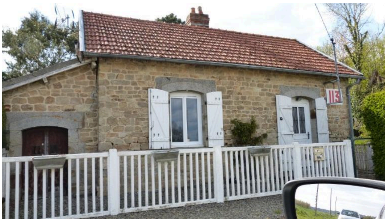
Maison de garde-barrières
