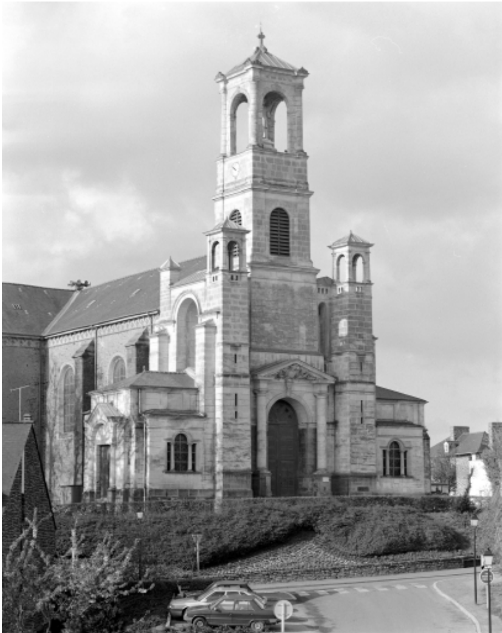
Elévation nord : vue générale
