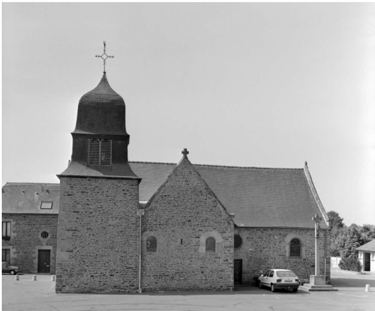
Elévation Nord : vue générale
