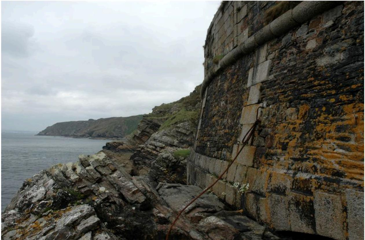
Vue de la batterie de Cornouaille : mur de soutènement de la batterie. Soubassement, chaînes, cordon, gargouilles et encadrement des créneaux en granite, remplissage en moellons de schiste
