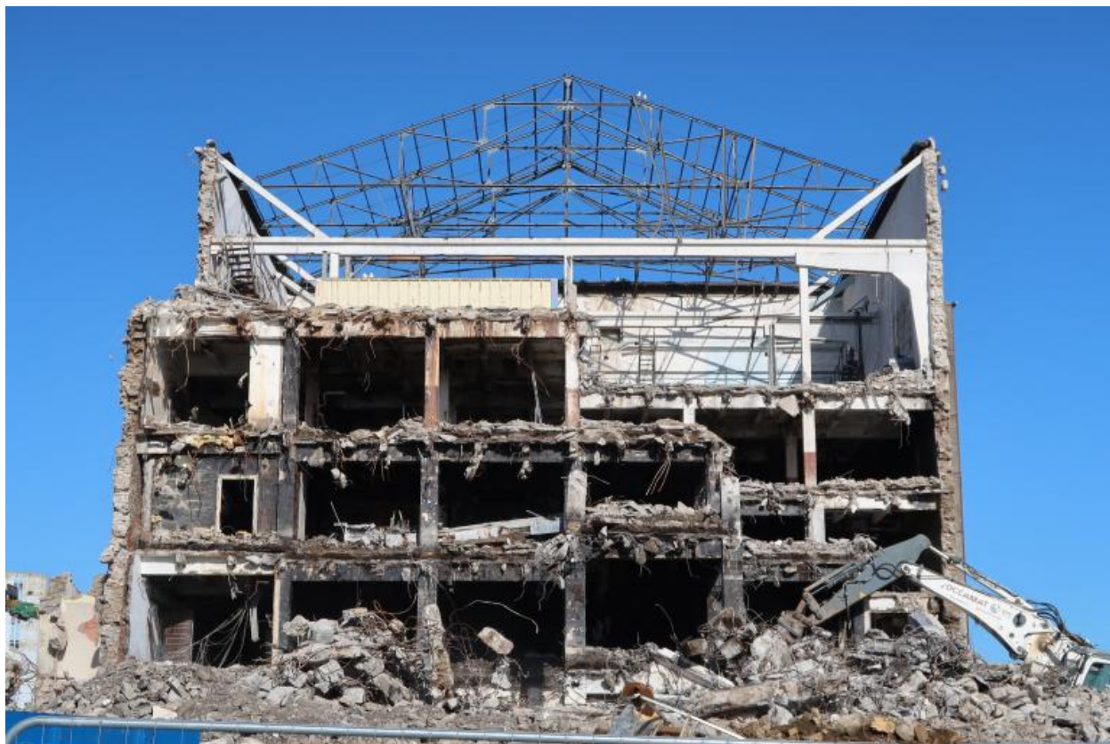
Déconstruction de l'ancien frigorifique, 10 mars 2022 : côté ouest, infrastructure porteuse, charpente métallique
