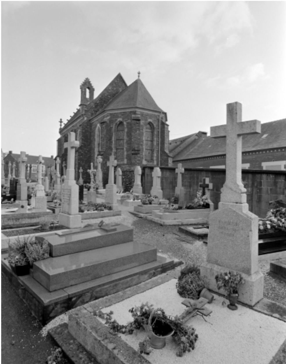
Elévation Sud-Ouest : vue de situation
