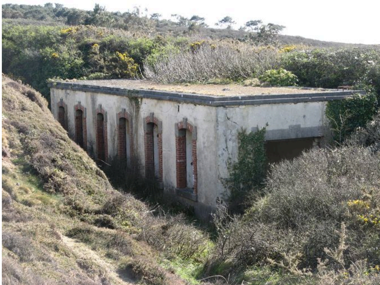
Usine électrique de la batterie de Kerviniou
