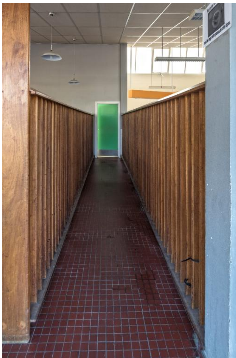
Réfectoire, rez-de-chaussée haut : couloir d'accès aux cuisines.
