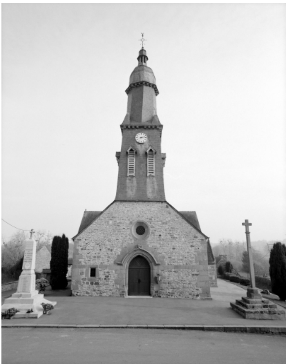
Elévation Ouest : vue générale
