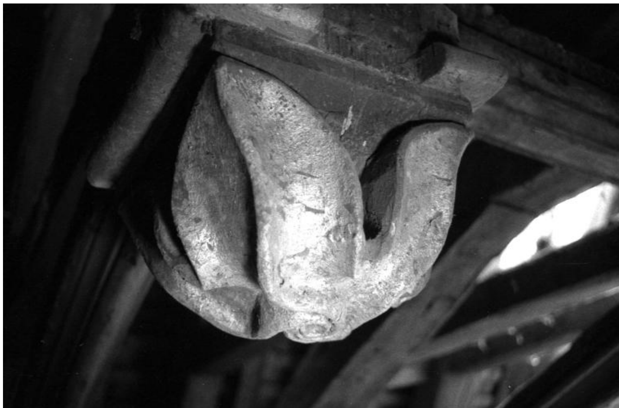
Charpente, détail de la clé 30.
