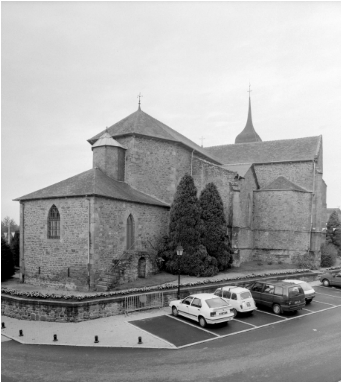
Elévation Nord-Est : vue générale
