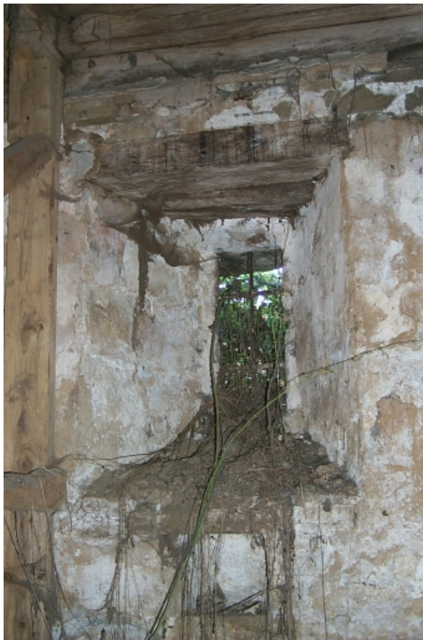
Intérieur, mur sud, baie
