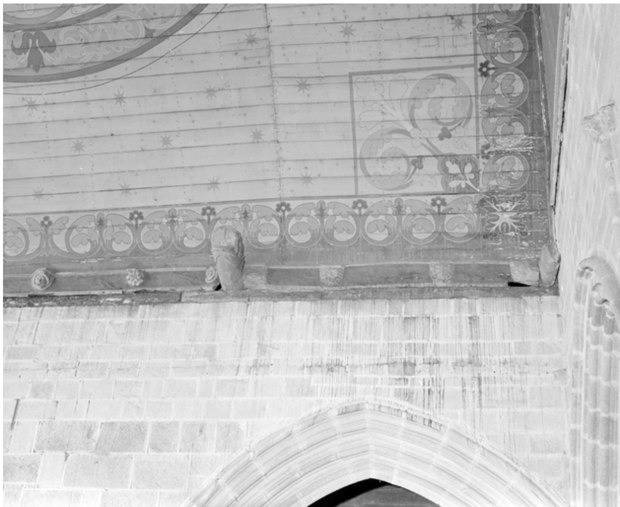
Sablère n°7, bras sud, mur ouest, partie droite
