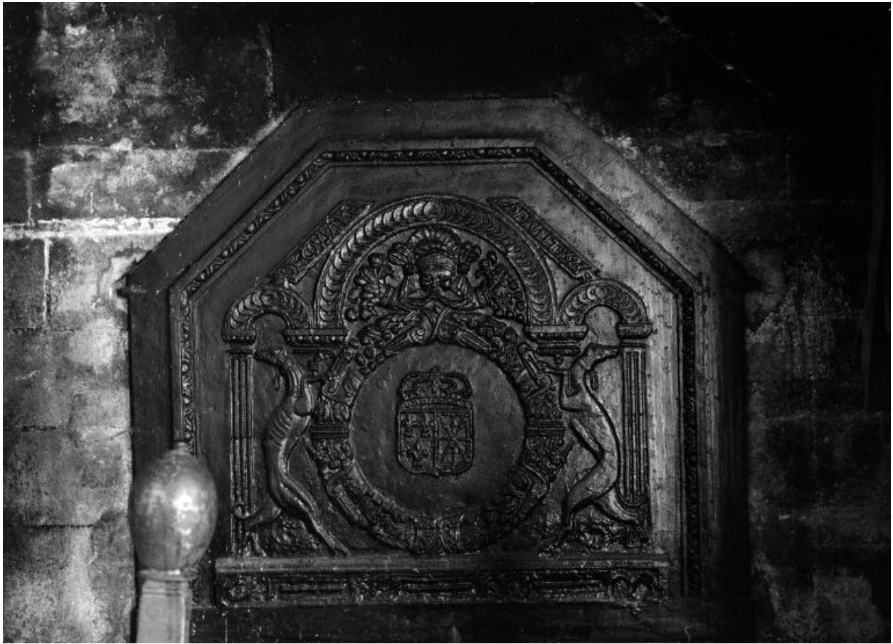
Cheminée est du rez-de-chaussée, plaque de cheminée
