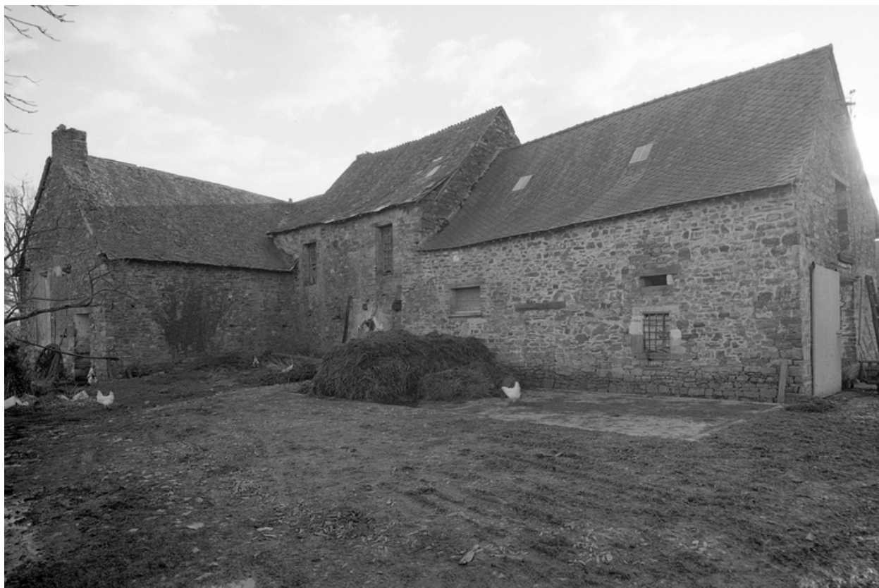
Vue générale, nord-est.
