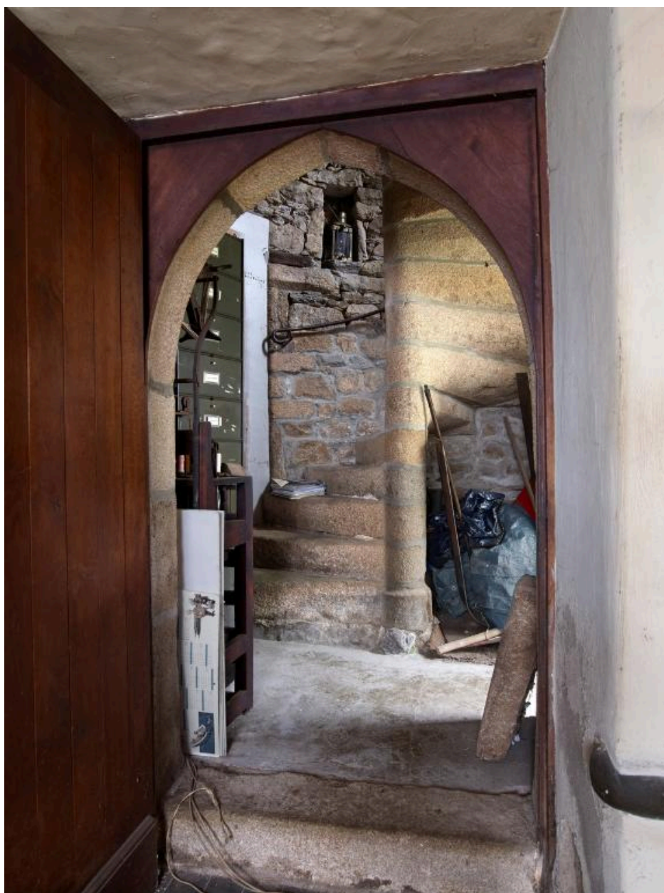
Tour d'escalier. Vue intérieure prise du rez-de-chaussée
