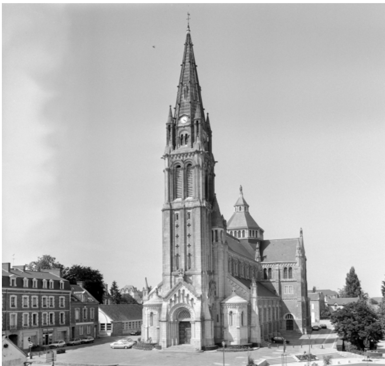
Elévation Sud : vue générale
