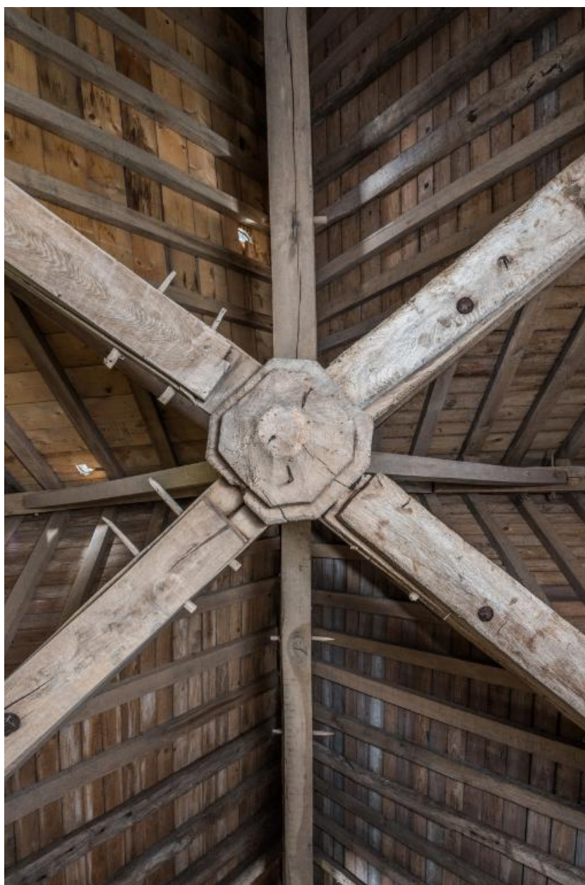
Vue de la clef de voûte de la charpente à la croisée du transept.
