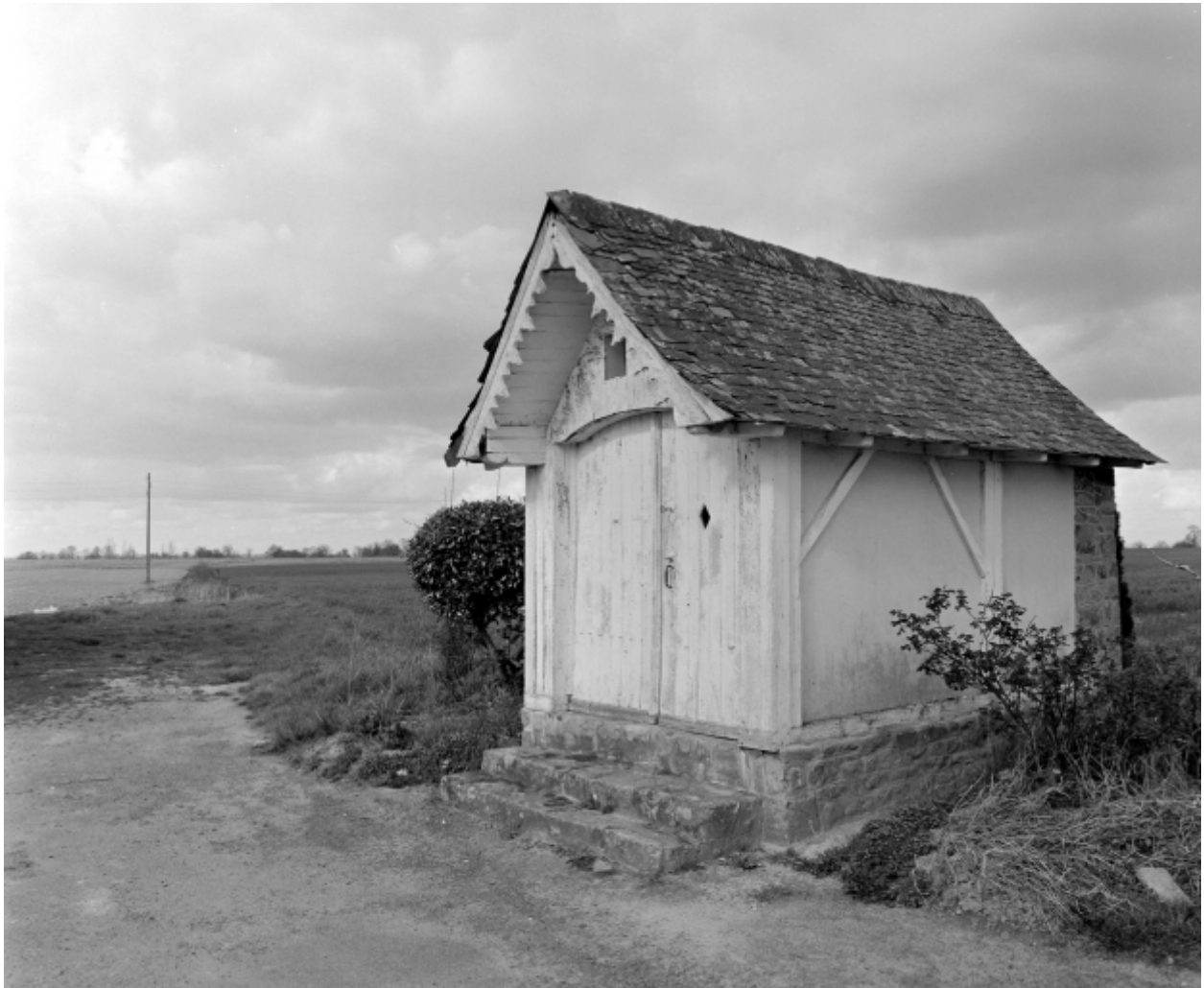
Elévation Ouest : vue générale
