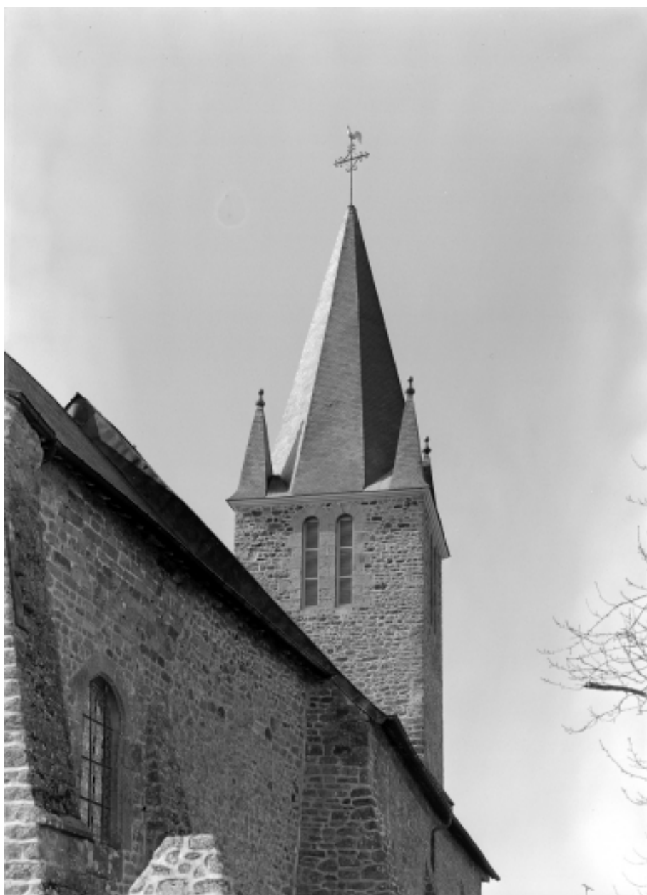
Elévation est, clocher, partie haute : vue générale
