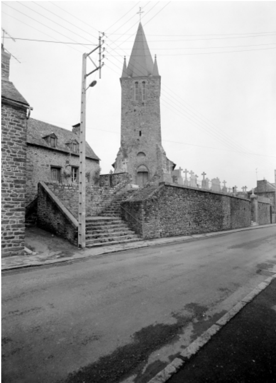
Elévation ouest : vue de situation
