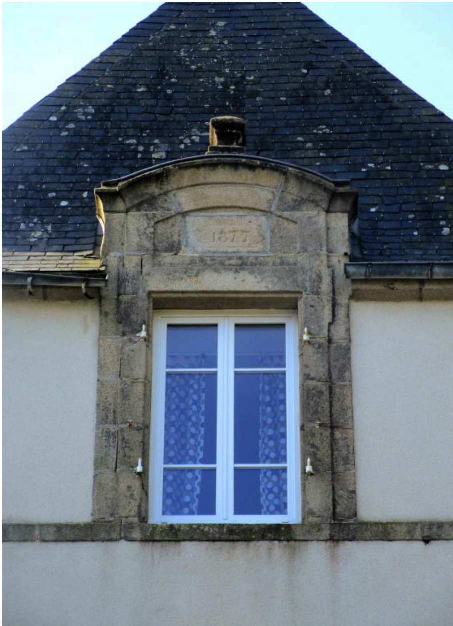
Elévation nord, étage. Détail de la date portée : 1877. (2023)
