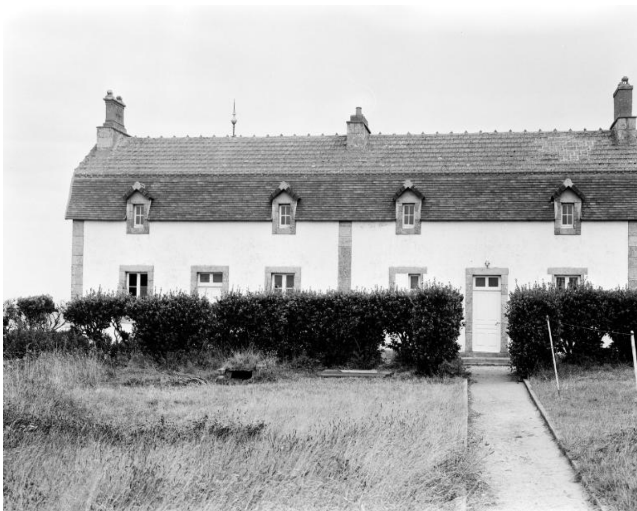
Bâtiment ouest, vue générale sud
