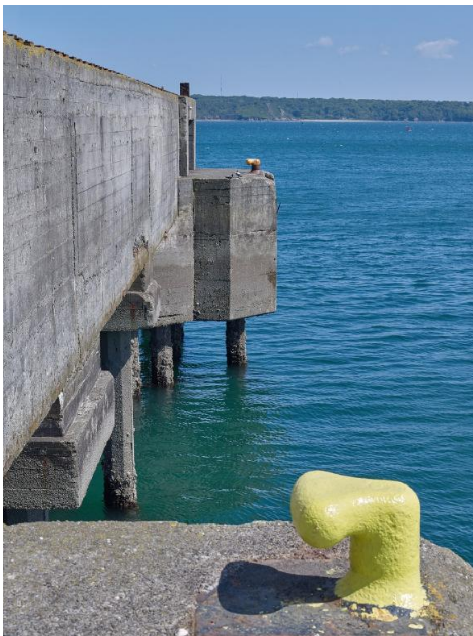
Poste caboteurs : caissons sur pieux en béton armé
