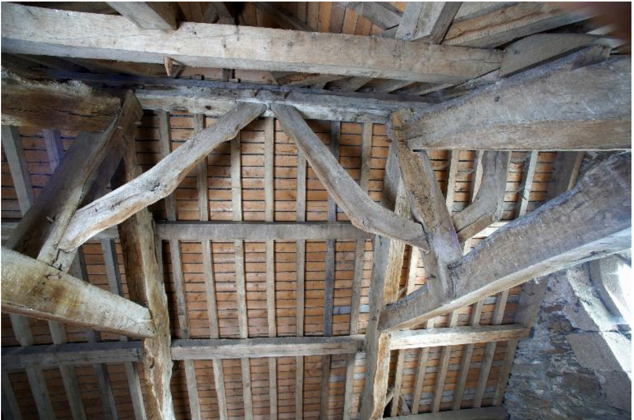
Charpente au -dessus du choeur.
